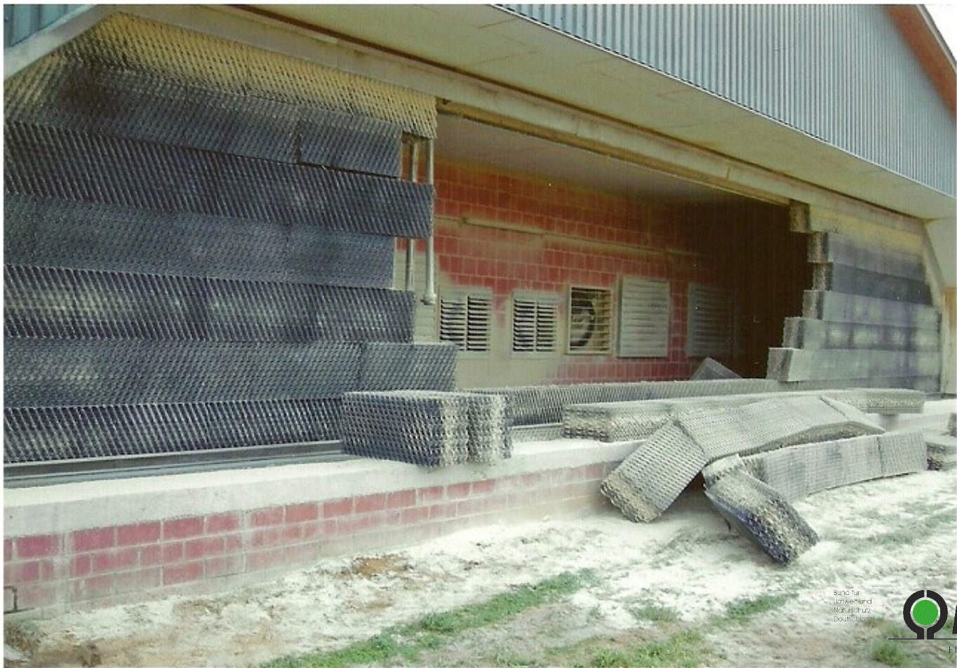
Abbildung 1 - Herausgebrochene Wabenfilterwand
